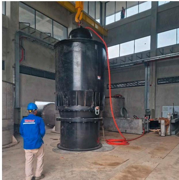
SAF-насос Bedford с производительностью 10 000 литров в секунду во время установки на объекте
