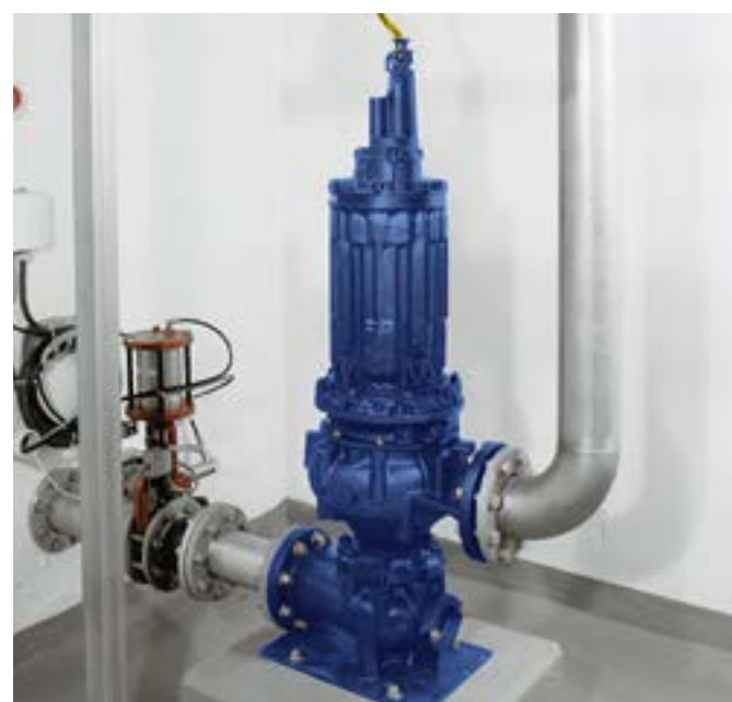
Bomba instalada en seco, motor con refrigeración por convección.
