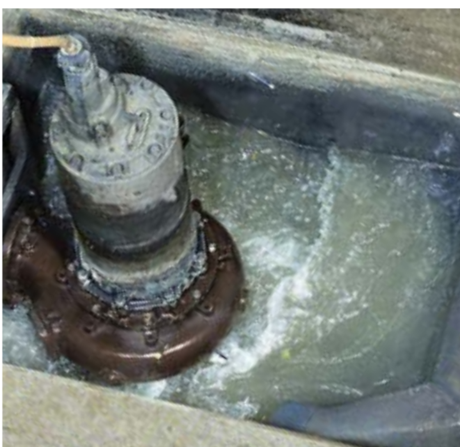
Bomba con motor inmergible para aguas residuales
