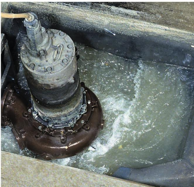
Schmutzwasserpumpe mit eigengekühltem Motor im Pumpensumpf
