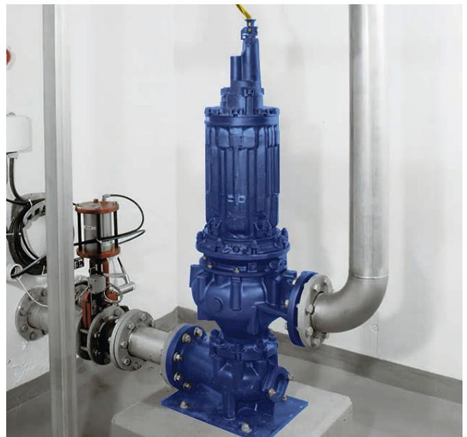
Trocken aufgestellte Abwasserpumpe, Motor mit Konvektionskühlung
